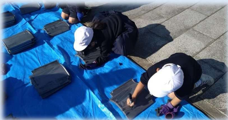
[参加型保存整備] 三角旧港(三角西港)・龍驤館の 葺替瓦へ名入れをする様子 (写真:宇城市教育委員会提供)
