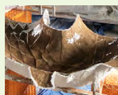
④石膏の内側にFRP※を4層塗る ※繊維強化プラスチック
