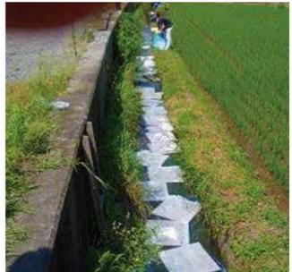
排水路から下流への油流出を防ぐため、オイル吸着マットを設置
