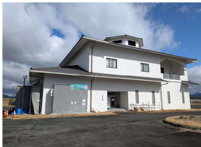
七城中央浄化センター
