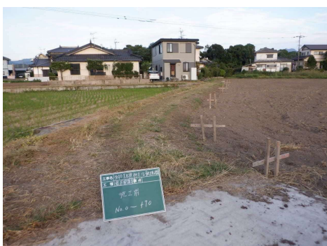
原材料による農道舗装（施工前）
