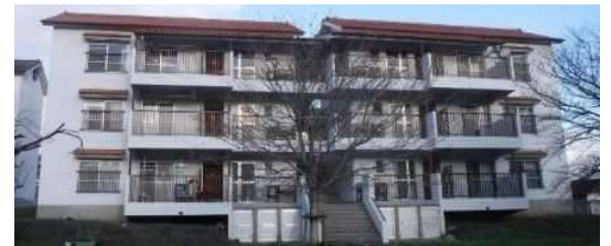
あさひが丘住宅の改修後
