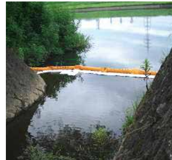
本川への油流出を防ぐため、オイルフェンスとオイル吸着マットを設置
