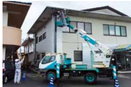
水道局舎の屋根部分に防鳥ネットを設置する組合員
