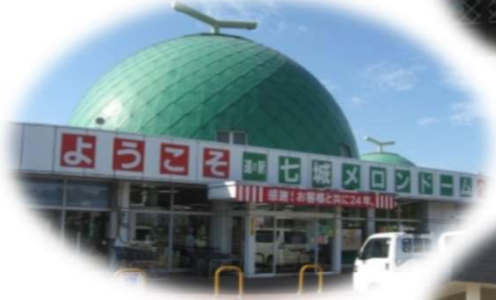
道の駅七城メロンドーム
