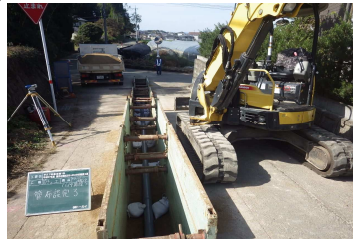
下水道管布設工事
