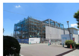
庁舎整備の様子
