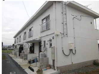
北宮団地外壁リフォーム
