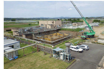
浄水場改築更新工事
