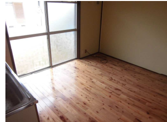
北宮団地内壁リフォーム
