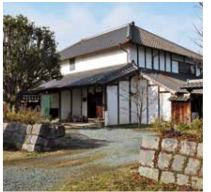
宮村家住宅主屋・石垣
