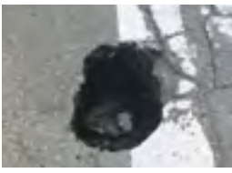
市道の陥没
