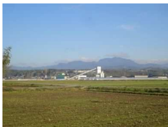
▲田園の中の生コンプラント
