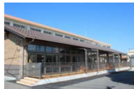
落成した新校舎。約1年間かけて建築しました
