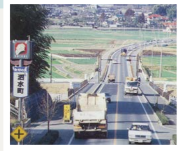
合志方面から洒水を望む。道の駅や温泉施設が建設される前の一枚
