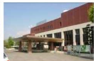
泗水総合支所
