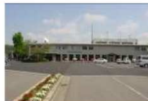
旭志総合支所
