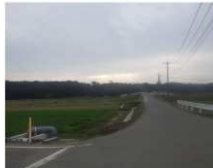
用水路改修後
