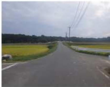
用水路改修前
