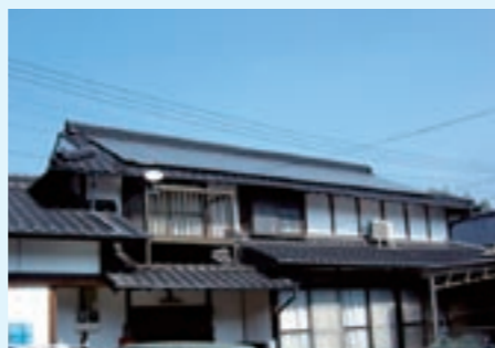
芹川さん宅の住宅用太陽光発電システム（H18年設置）
