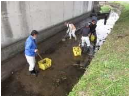
多面的機能支払事業(水路泥上げ作業)
