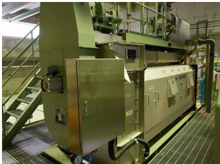
浄水センター改築更新工事(脱水機)
