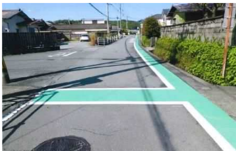
道路(椿山孔子堂線)の改修
