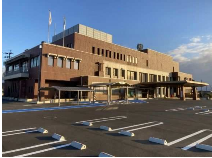
段差を無くした駐車場(泗水支所)
