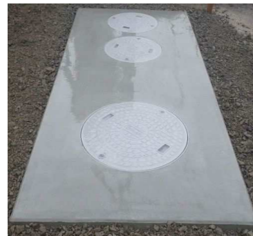
合併浄化槽の新設
