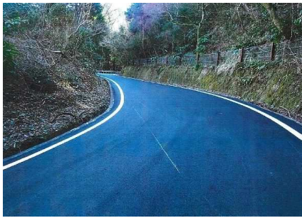
林業のための作業道開設
