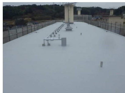
市営住宅(音光寺団地)の屋根の改修
