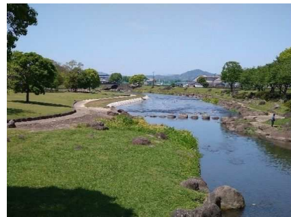
鴨川公園の改修
