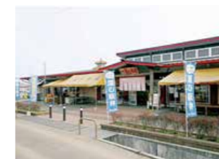
道の駅泗水養生市場
