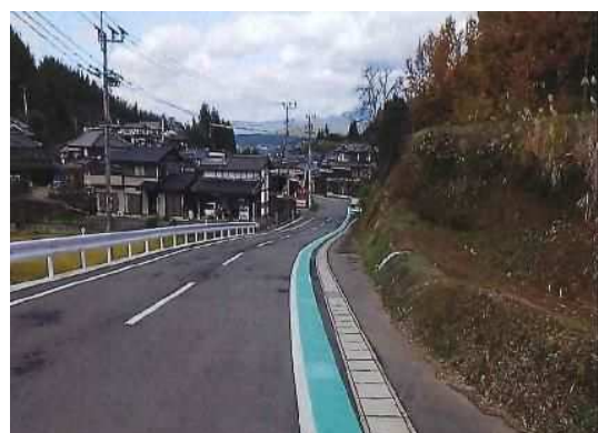
巨甲森2号線(区画線工事)
