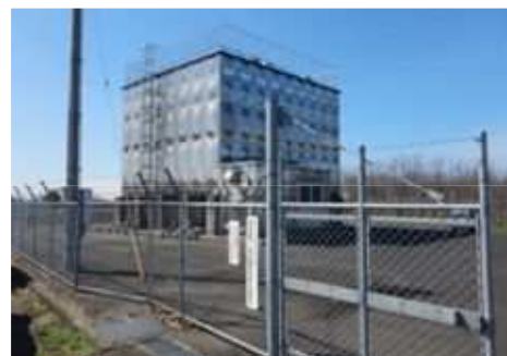
旭志西部地区水道施設
