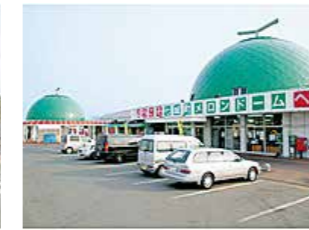
道の駅七城メロンドーム
