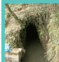
1704年、今・赤星・森北地区の約100haの水田への灌漑用水のために、山を掘削して作られた隧道(水のトンネル)である。全長168間(約302m)で三代目河原空左衛門の三大事業の一つとされる。
