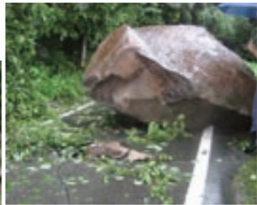
(上) 7月21日に発生した県道原立門線の落石(原・立門区) (左) 8月27日に発生した龍門・中片地区の落石
