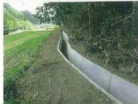
用水路改修後
