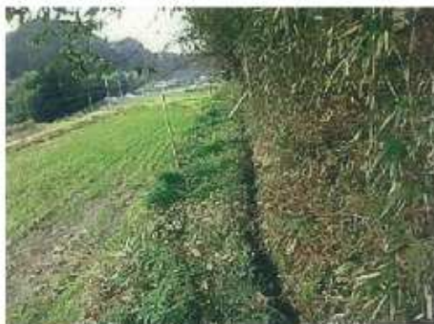
用水路改修前
