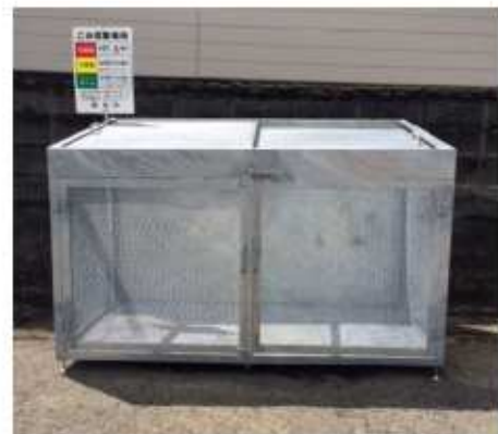
柿木平区ごみステーション(H29.6月新設)
