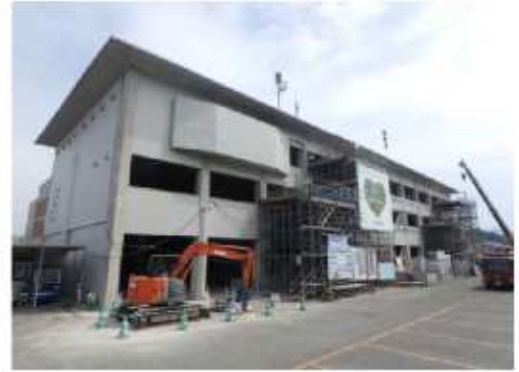
改修中の既存庁舎
