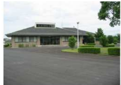
泗水浄化センター
