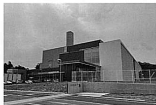
クリーンの森合志（ごみ焼却施設）
