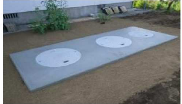
設置工事完了
