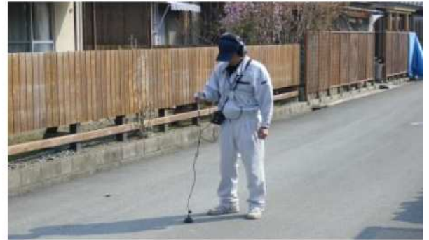
▲漏水調査状況
