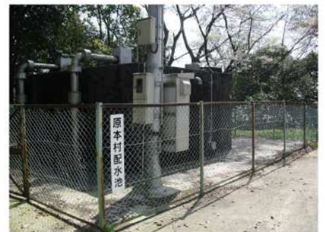
▲原本村配水池
