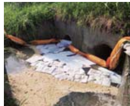
油の流出を防ぐためにオイルマットとオイルフェンスを設置
