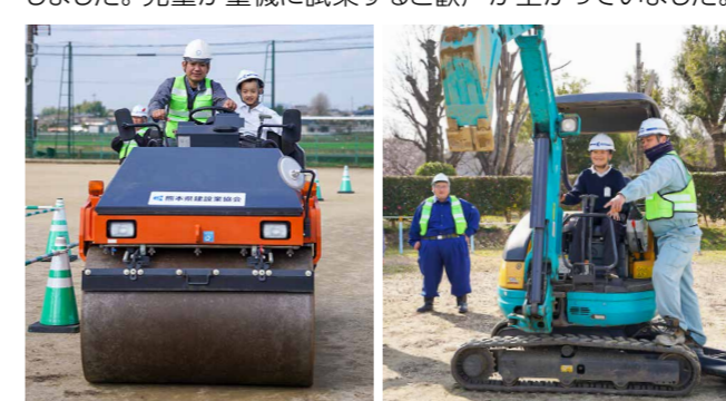
前川支部長は「ボランティア作業の見学や重機の試乗体験を通して、建設業のことを知って興味を持ってくれたらうれしい」と話しました
