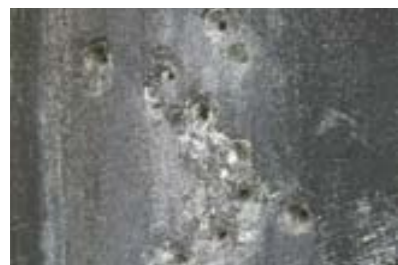
木造格納庫跡に残る機銃弾の跡
