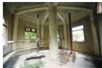
給水塔内部。設備の一部が残っている
