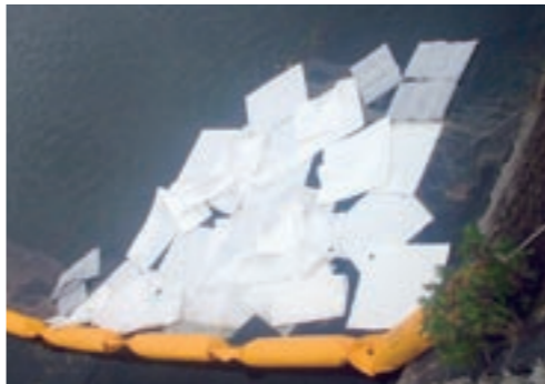
オイルフェンスと吸着マットによる油流出処理
