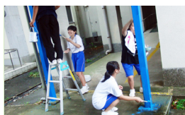
渡り廊下のペンキ塗り
