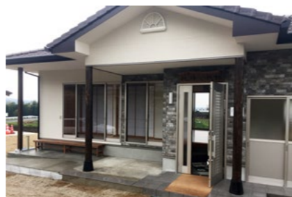
新しく建設された九の峰区公民館
