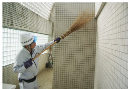
日頃の清掃では手の届かないところまで清掃しました
