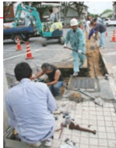
菊池市役所本庁舎前で「散水栓の設置」のための作業をする組合員たち
