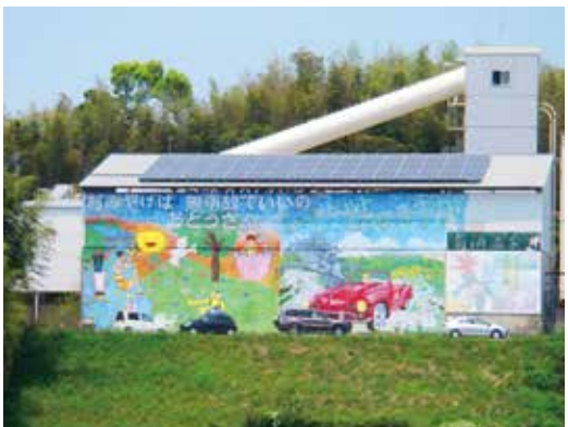
現在の外壁(森北生コン有限会社)
