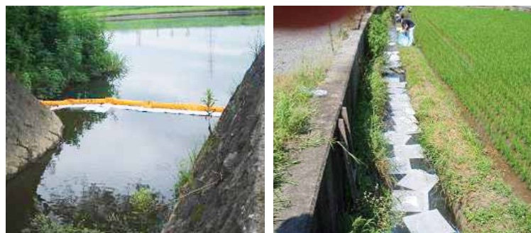
本川への油流出を防ぐため、オイルブエンスとオイル吸着マットを設置 排水路から下流への油流出を防ぐため、オイル吸着マットを設置
