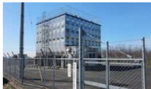
旭志西部地区水道施設
