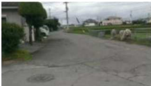
管渠工事布設箇所
