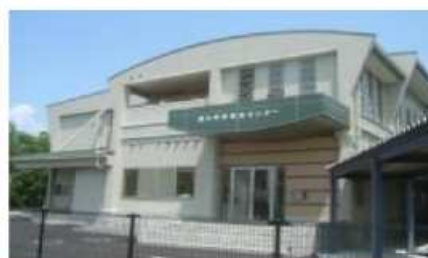
泗水学校給食センター
