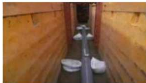
下水道管布設状況
