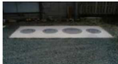
設置工事完了
