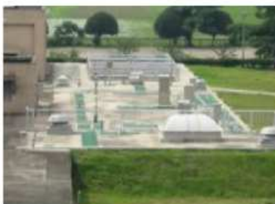
3系反応タンク設備増設 (前期実施)
