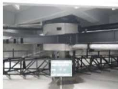
No.1最初沈殿池更新 (前期実施)
