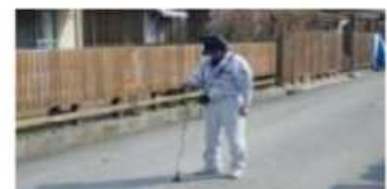
漏水調査状況
