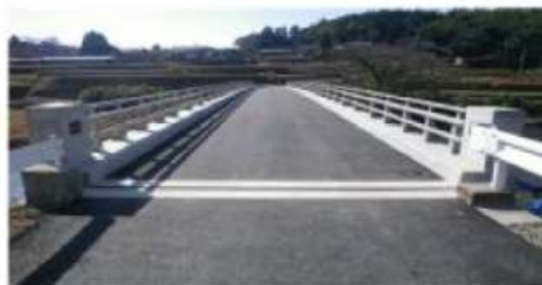
細永橋【修繕後】
