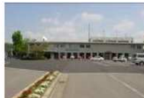
旭志総合支所
