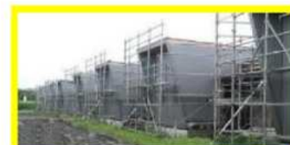
朝日東団地建替事業(建設中の住宅)
