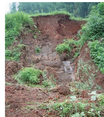
農地被災箇所
