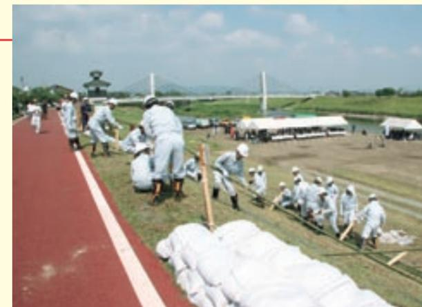
堤防の裏のり面に生じた亀裂の拡大を防ぐ「繋ぎ縫い工法」を披露する、国土交通省班の班員たち
