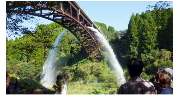
豊潤橋は橋の上を人が通り、橋の下を水が流れる農業用水パイプライン。年に1度、土砂を取り除くために放水しています
