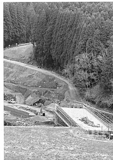
▲古川伊倉線・改修工事
