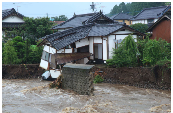
旭志伊坂区伊坂橋下流左岸
