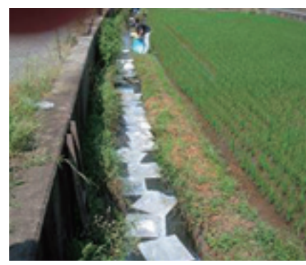
排水路から下流への油流出を防ぐため、オイル吸着マットを設置
