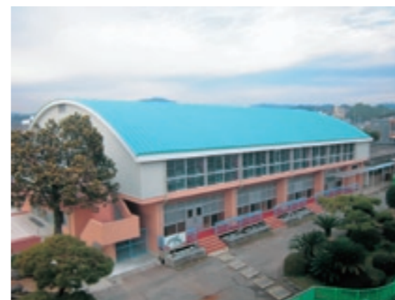
耐震化された限府小体育館
