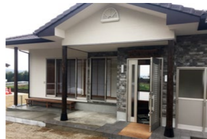
新しく建設された九の峰区公民館
