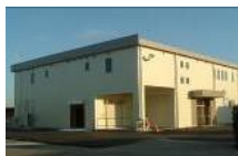
集出荷貯蔵施設
