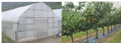
ハウス・樹園地の再整備・改修
