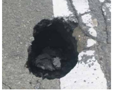
市道の陥没
