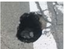
市道の陥没
