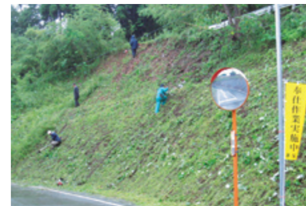
雨で足元が滑りやすく、傾斜が急な法面は大変な作業でした
