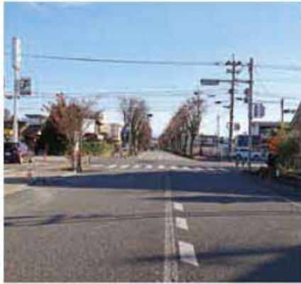
(采町交差点から市役所方向へ) 隈府中央線
