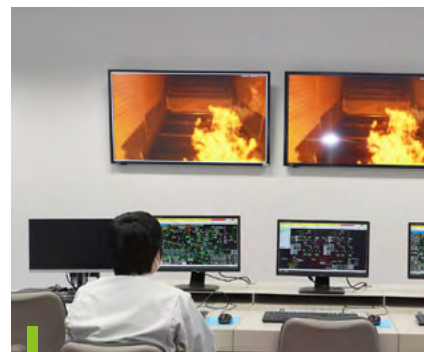
施設全体を管理する中央制御室。ここでごみの搬入や焼却炉内部、ごみピット内のようすを確認する
