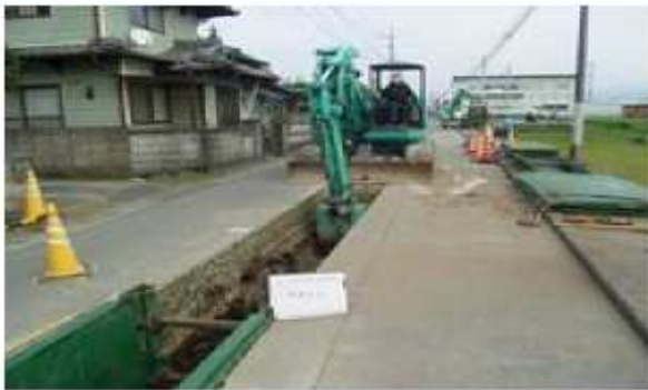
路面の掘削状況
