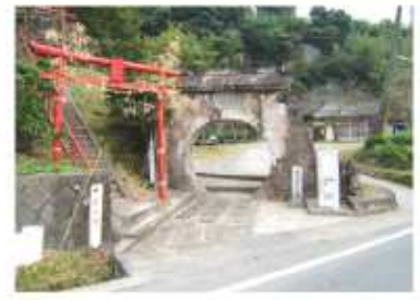
円通寺の石門(県指定建造物)
