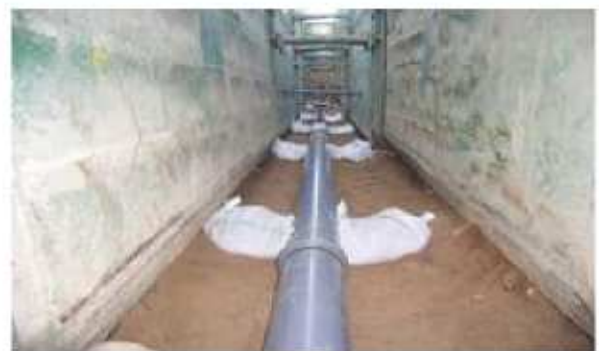
下水道本管敷設状況
