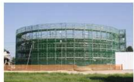
▲泗水桜山配水池
